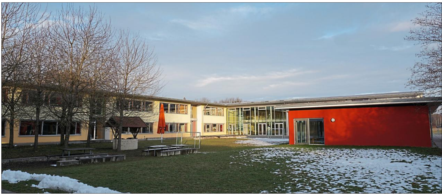
Blick auf den großzügigen Pausenhof der Herzog-Georg-Schule.
